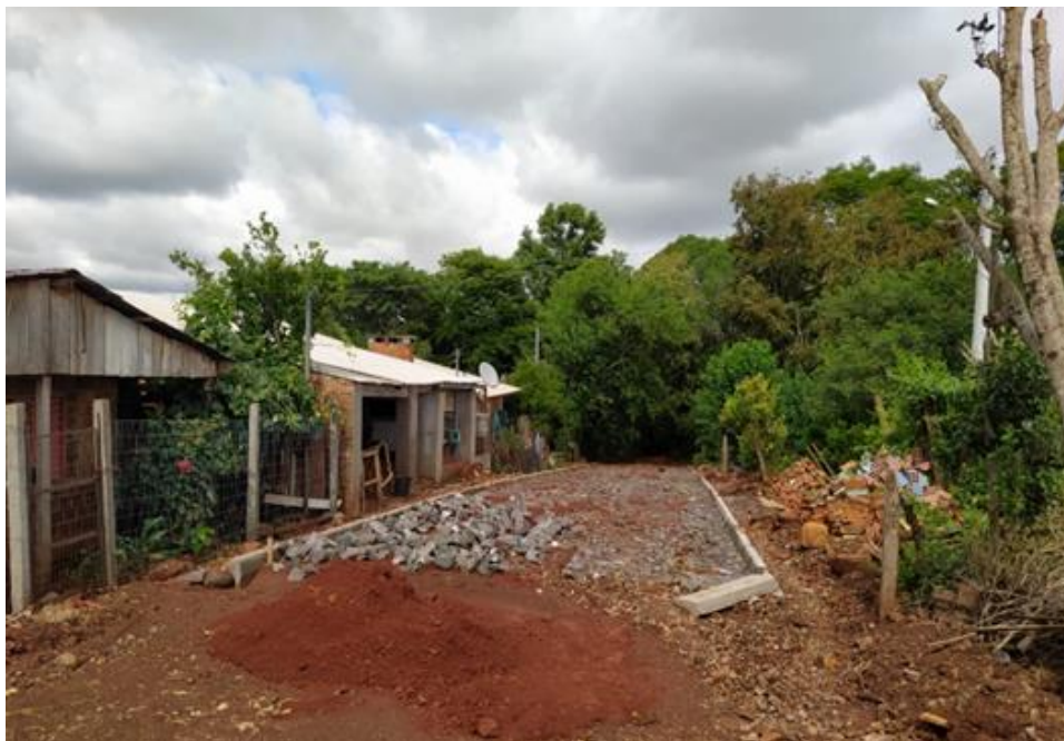
Calçamento da Rua dos Imigrantes (entre a Rua Ijuí e a área verde – Esperança II)
