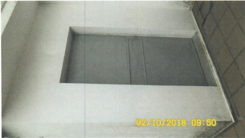
PORTA REFORMADA PINTUARA E FECHADURA
