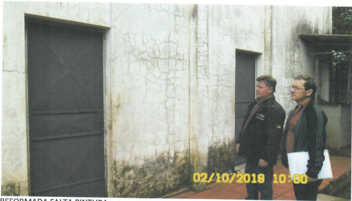
REFORMADA FALTA PINTURA
