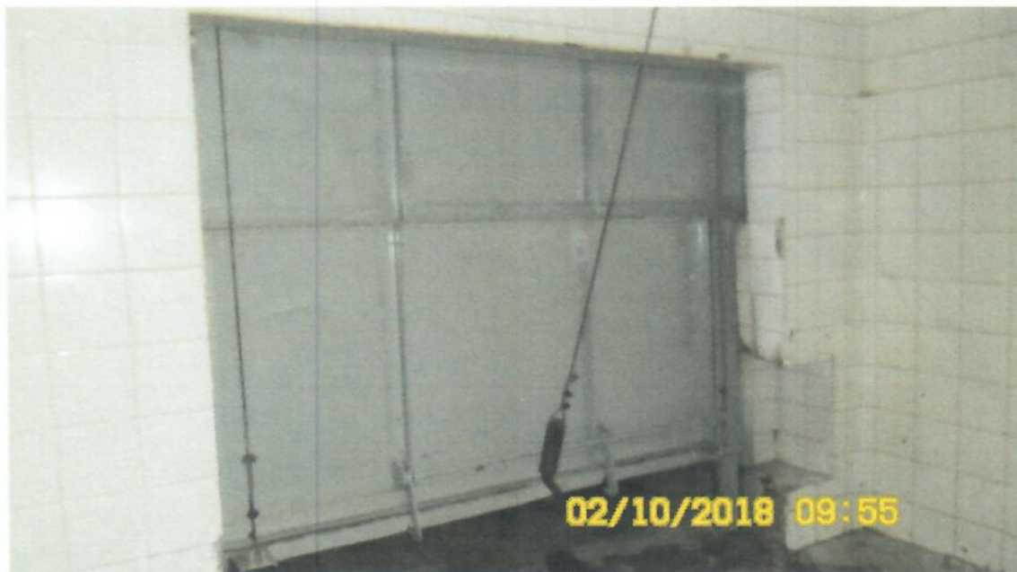
PINTURA PLATAFORMA DE ATORDOAMENTO
