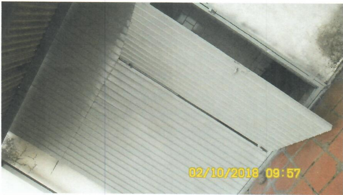
REFORMA PINTURA EXTERNA
