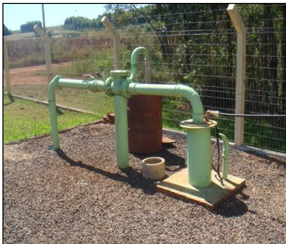
Foto 07: Detalhe do Poço GMI-19, executado conforme novos padrões da CORSAN para poços tubulares.
