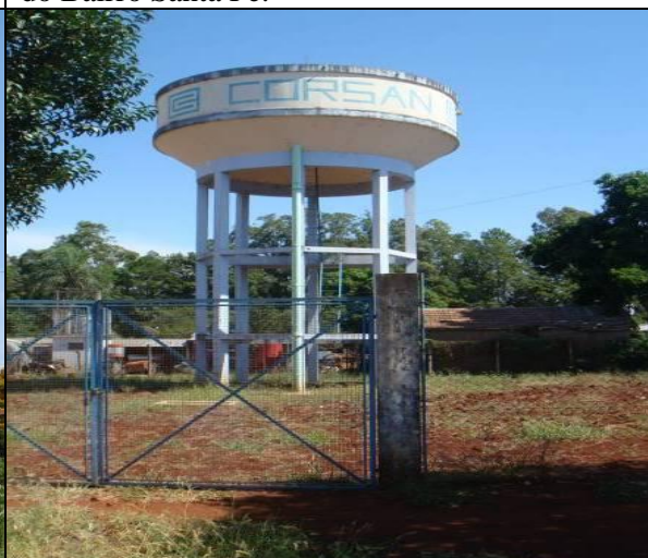
Foto 12: Reservatório elevado padrão Intze com capacidade de 150m 3 .
