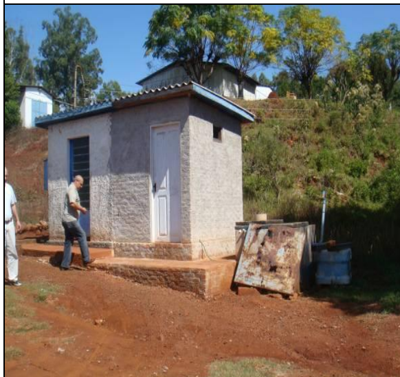
Foto 03: Vista do Poço GMI-15, para abastecimento de água da cidade.
