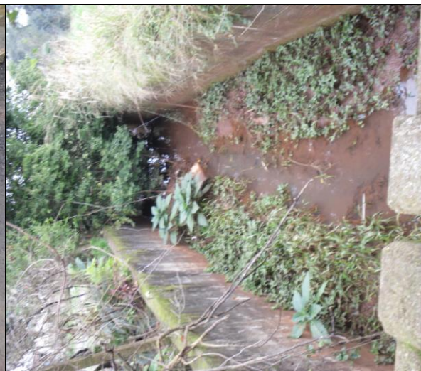
FOTO 04 – Detenção e Retenção
