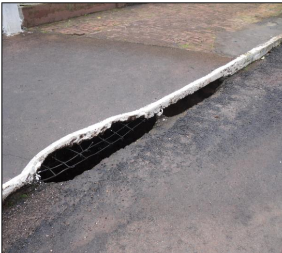
FOTO 03 – Drenagem urbana de águas pluviais
