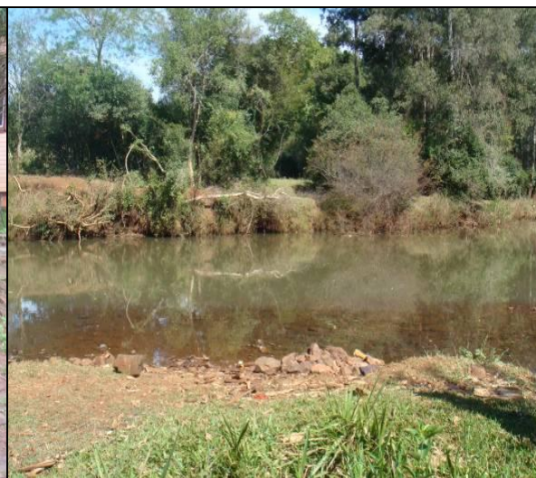
FOTO 06 – Disposição final das águas pluviais
