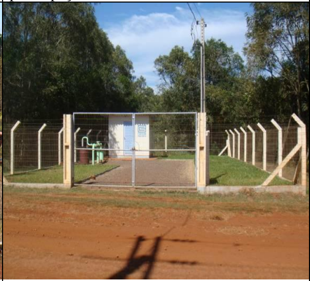
Foto 06: Vista do Poço GMI-19.
