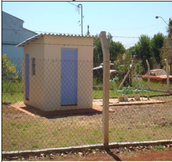
Foto 05: Vista do Poço tubular GMI-04.
