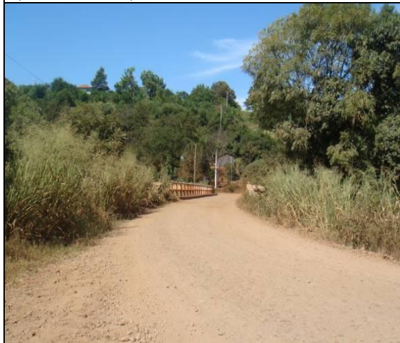
Foto 21: Ponte para travessia do rio Comandaí, próximo da área urbana da cidade.
