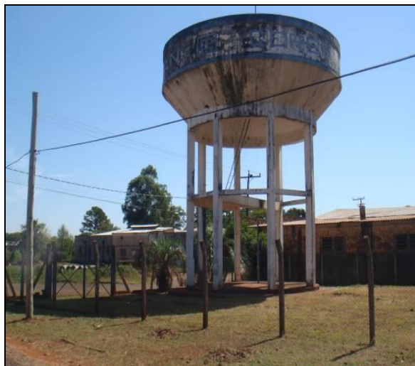
Foto 13: Reservatório Elevado padrão Intze com capacidade de 250m³.
