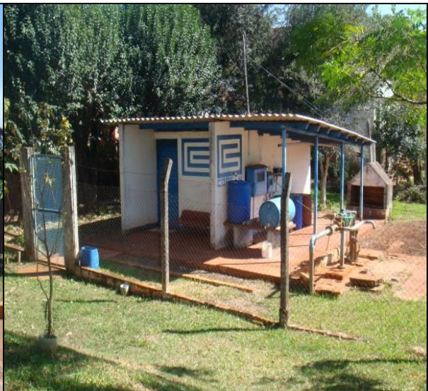
Foto 02: Vista do Poço Tubular GMI-03 para abastecimento de água potável da cidade.
