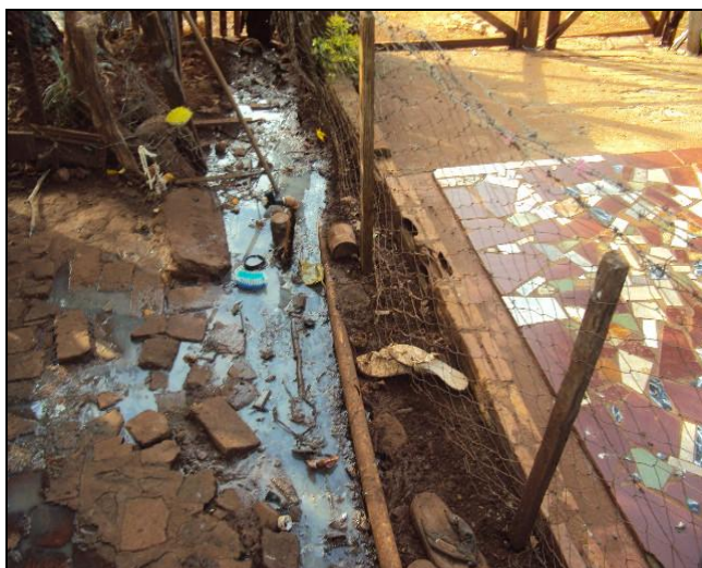
Foto 03 – Esgoto a céu aberto
