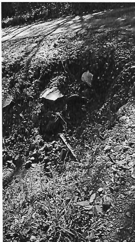
Foto 08 – Rede existente (Rua Orestes Arruda da Silva)
