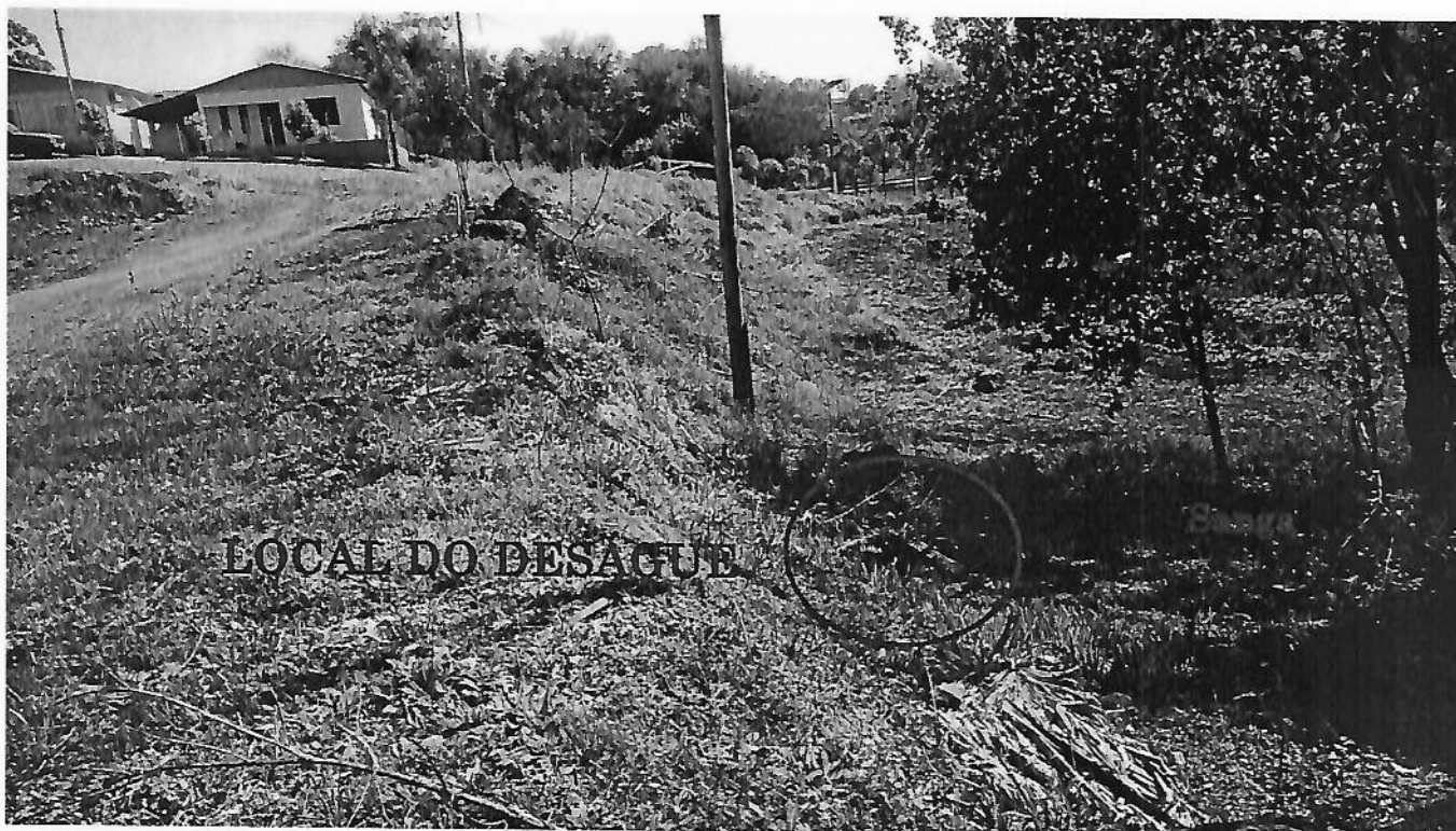
Foto 01 – Local onde será feito o deságue da drenagem na sanga
