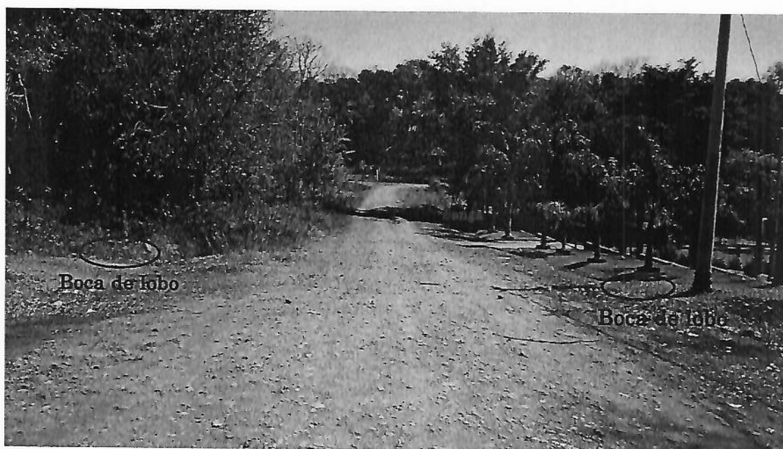
Foto 03 – Bocas de lobo da Rua A
