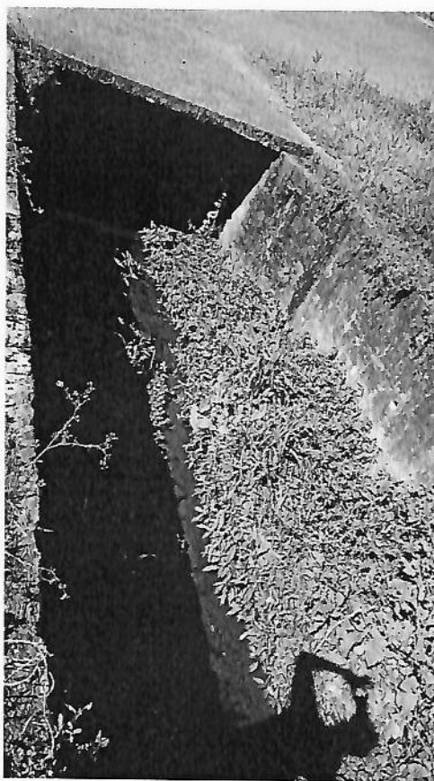
Foto 07 – Galeria (Rua São Borja)
