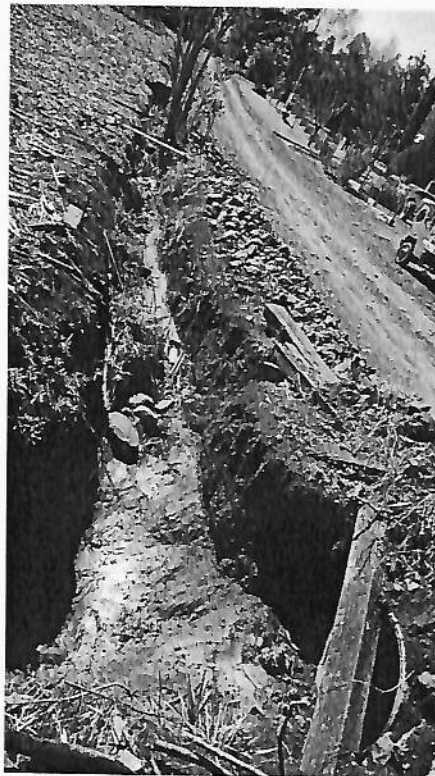
Foto 09 – Deságue em rede existente (Rua Orestes Arruda da Silva)
