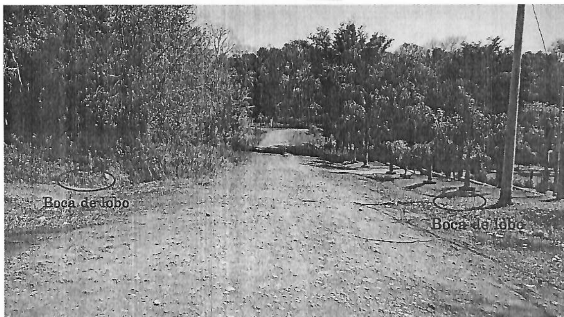
Foto 03 – Bocas de lobo da Rua A
