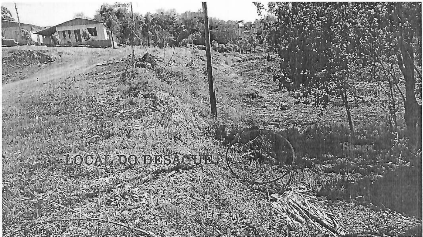
Foto 01 – Local onde será feito o deságue da drenagem na sanga
