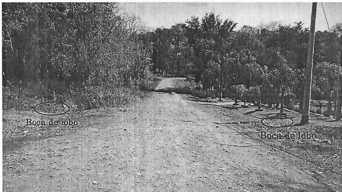
Foto 03 – Bocas de lobo da Rua A
