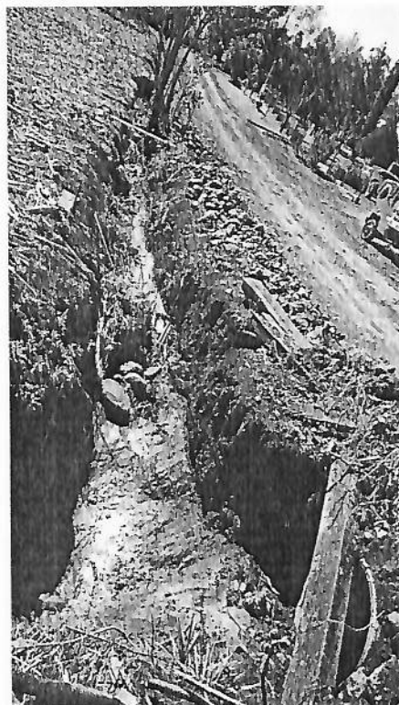
Foto 09 – Deságue em rede existente (Rua Orestes Arruda da Silva)
